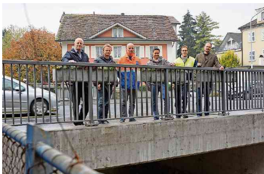
Heiner Graf (Swissplan), Thomas Schmid (Bauleiter), Michael Studhalter (Bauführer), Roberto Scappaticci (Teilprojektleiter), Silvio Moser (Projektleiter) und Christoph Meyer (Leiter Tiefbau) auf der neuen Bünzbrücke.
